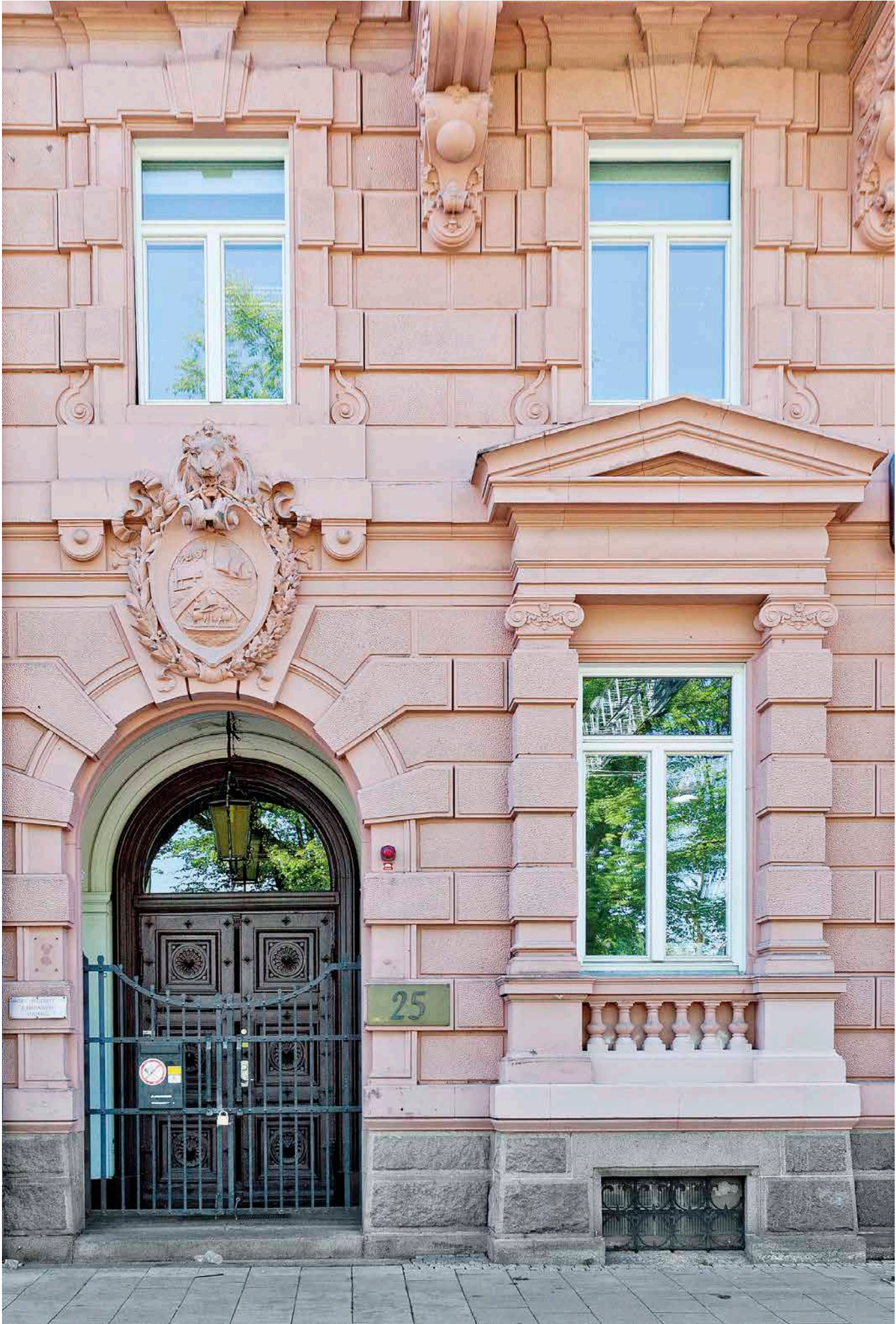
Södra vägen 25, Göteborg.
