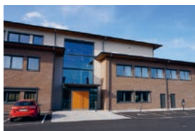
Alfagatan 20 Nybyggd kontorsfastighet 2019. Fastigheten innehåller ca 1 785 kvm uthyrbar yta.
