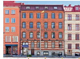
Stora Badhusgratan 28 B Hotellfastighet byggd 1929 och totalrenoverad 1986 med 1 750 kvm lokalyta.
