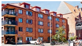
Nordhemsgatan 23 Bostadsfastighet i Linnéområdet byggd 1994 med 55 lägenheter.
