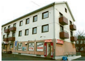
Mötesplatsen 1 Bostads- och butiksfastighet på Hisingen byggd 1946 och totalrenoverad 1987 med 10 lägenheter och 360 kvm butikslokaler.
