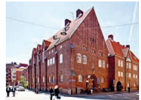
Tredje Långgratan 18 Fastighet uppförd 1913 i nationalromantisk stil med 2 500 kvm lokaler.
