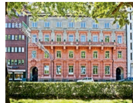
Södra Vägen 25 Kontorsfastighet uppförd 1895 i Göteborgs centrum med cirka 2 000 kvm uthyrbar yta. Lokaler är i dag uthyrd till en friskola.
