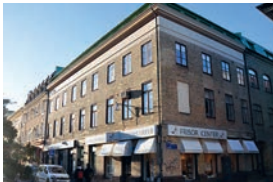
Kyrkogatan 24 Butiks- och kontorsfastighet uppförd 1929 belägen i centrala Göteborg. Fastigheten innehåller ca 1 500 kvm uthyrbar yta.
