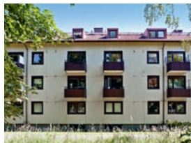
Björnekärrsgatan 2 Bostadsfastighet uppförd 1947 och ombyggd 1993 med 34 lägenheter.
