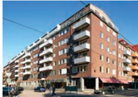
Baldersgatan 6-10 Bostads- och kontorsfastighet med 73 lägenheter och 3 lokaler. ROT-renoverad 2015.
