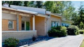
Skinnefjällsvägen 4 Bostadsfastighet uppförd 1990 och renoverad 2016 belägen i Mölnlycke, Härryda. Fastigheten innehåller 521 kvm uthyrbar yta.
