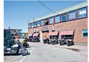
Turbingatan 10 Lager- och industrifastighet på Hisingen byggd 1959 och tillbyggd 1980 med 1 530 kvm lokaler.
